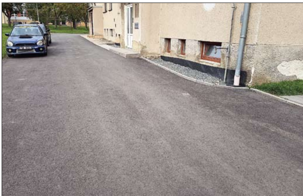
Oprava komunikace u bytovek za školou
