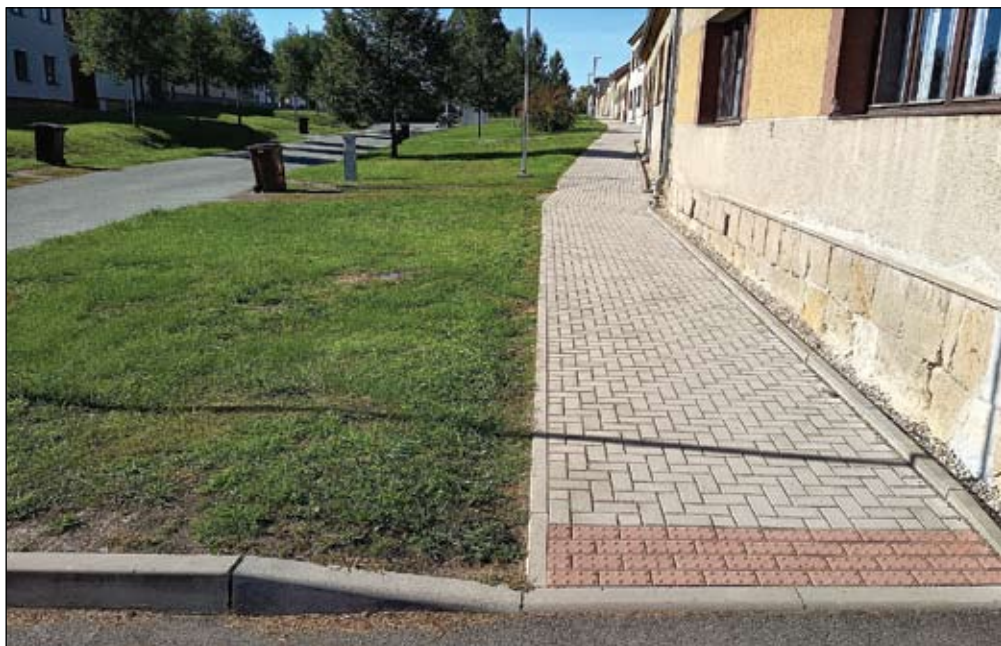
Rekonstrukce chodníku včetně nového veřejného osvětlení
