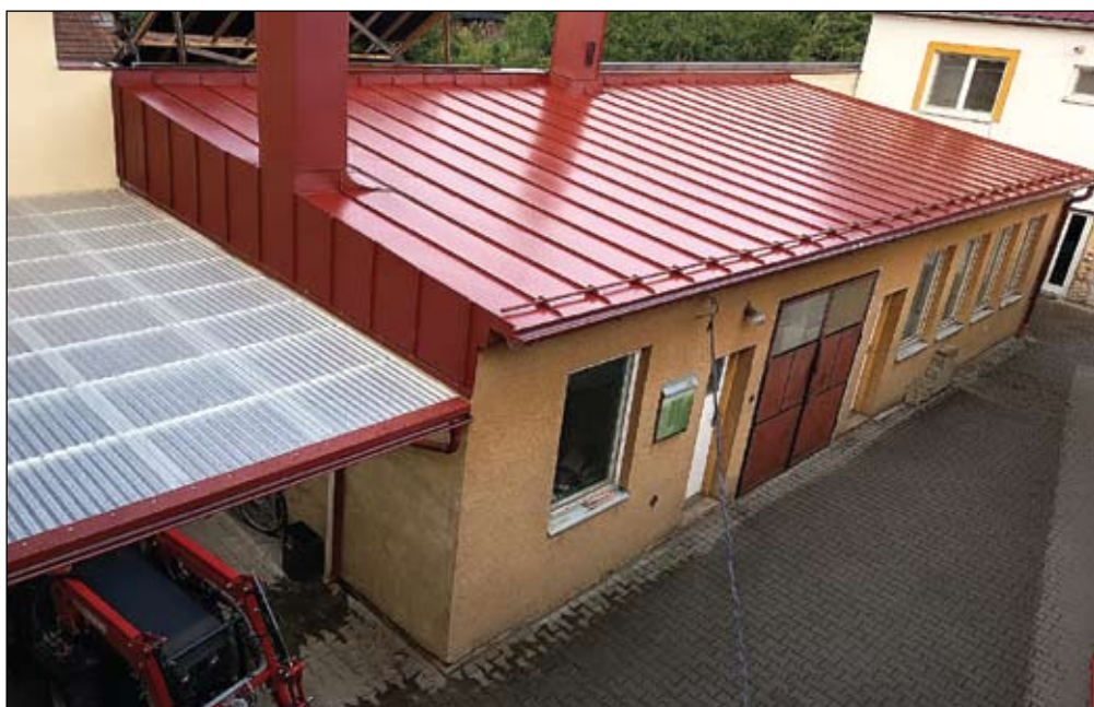
Rekonstruované střešní pláště hospodářských budov ve dvoře radnice
