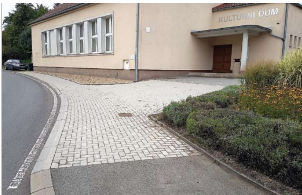
Oprava chodníku a celého prostoru před kulturním domem včetně nájezdových obrubníků
