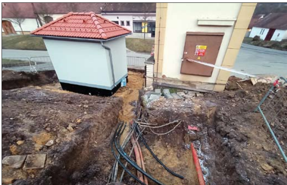
Rekonstrukce sítě nízkého napětí včetně nových trafostanic a nového veřejného osvětlení
