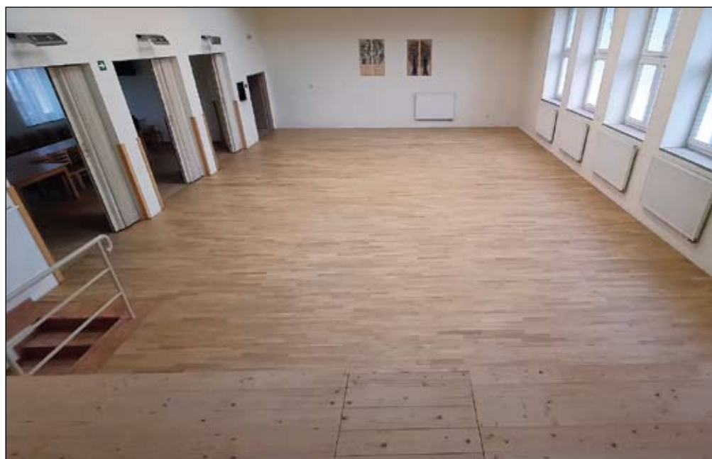
Oprava vnitřních prostor kulturního domu
