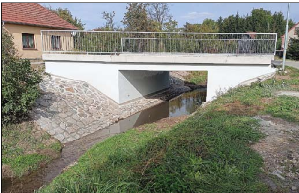
Rekonstrukce všech tří mostů přes potok Semíč
