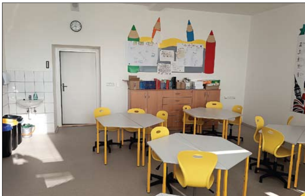
Přestavba bytu školníka na dvě nové odborné učebny
