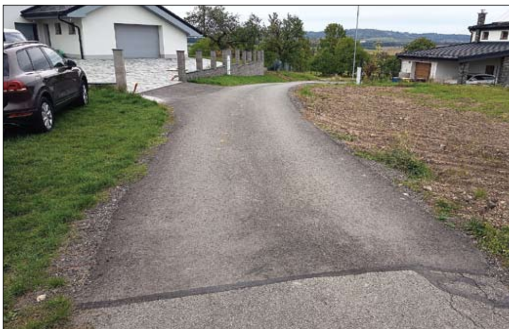
Oprava komunikace včetně rozšíření infrastruktury
