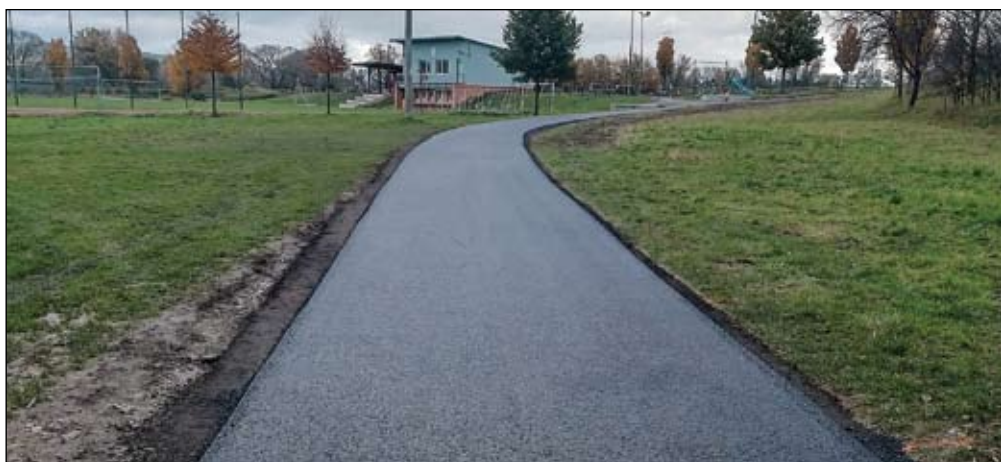
Oprava propustku u hřiště včetně nového povrchu komunikace
