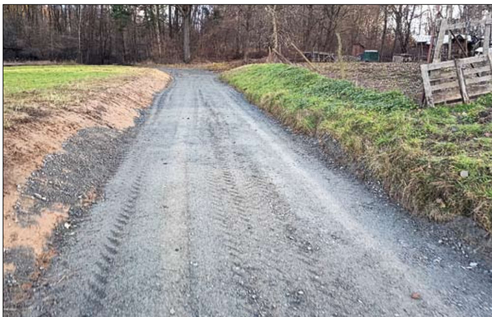
Zpevnění cest v lokalitě k Šebetovu
