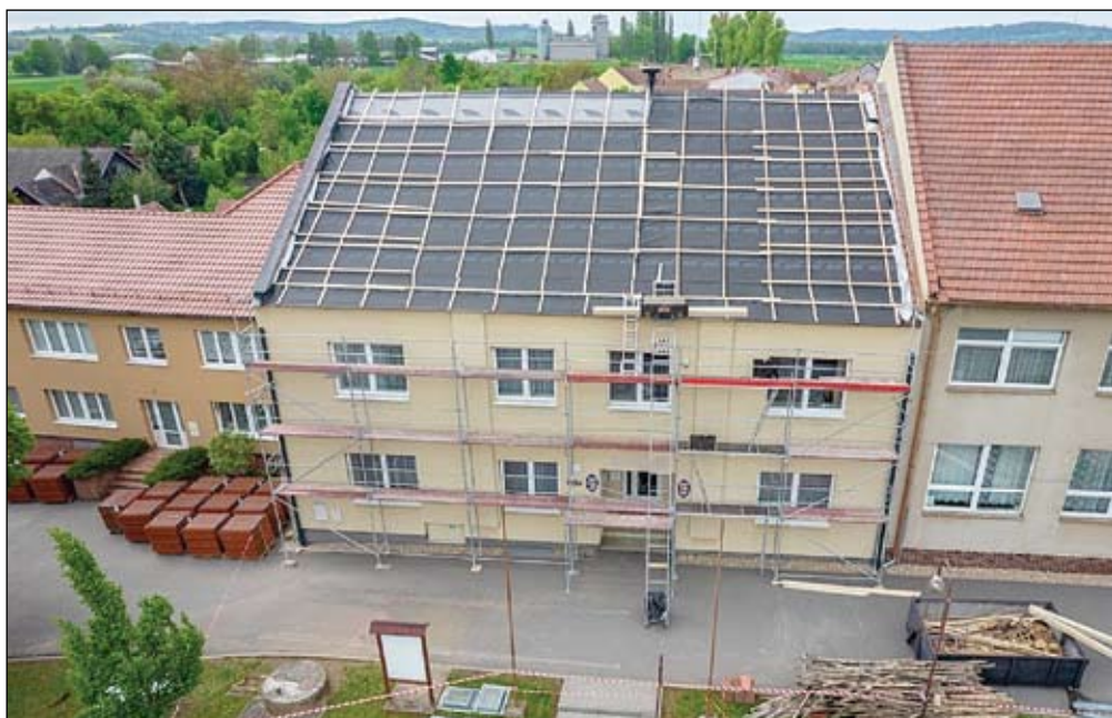
Rekonstrukce střechy radnice podpořená dotačním titulem
