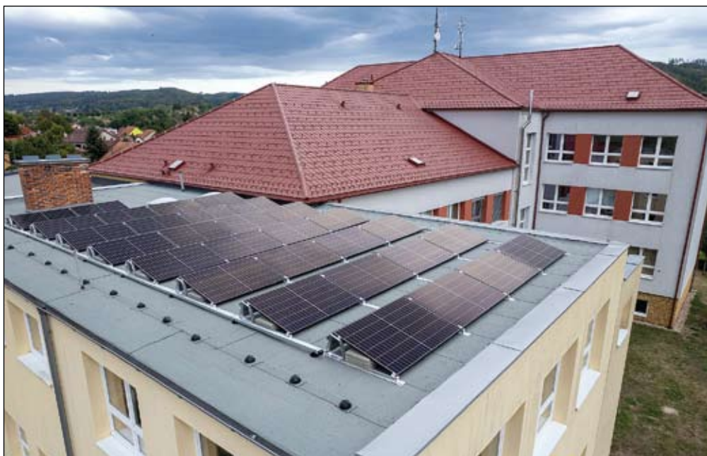
Oprava střechy Mateřské školy včetně umístění fotovoltaické elektrárny pro ZŠ a MŠ, obojí podpořeno dotací
