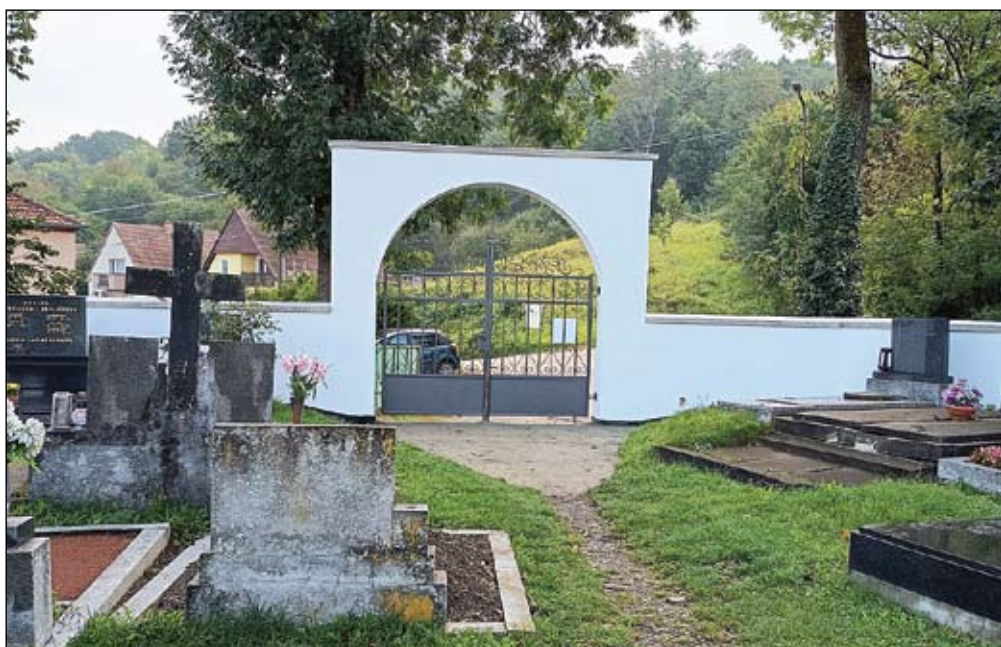
Oprava havarijního stavu hřbitovní zdi včetně vstupní brány – Investice rozdělená do dvou etap
