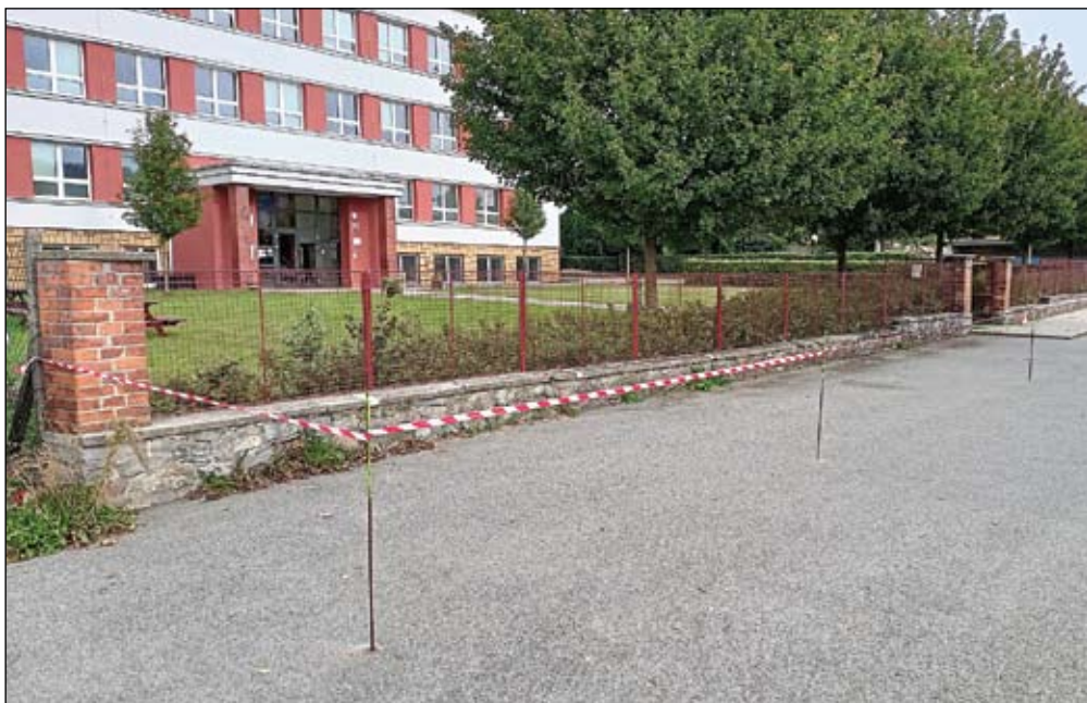
Výstavba nového oplocení základní školy včetně elektricky ovládané brány mobilními telefony
