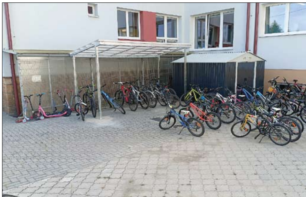
Oprava dlažby prostoru školy s instalací nového přístřešku na jízdní kola a garáže nového zahradního traktoru na sečení trávy v areálu školy
