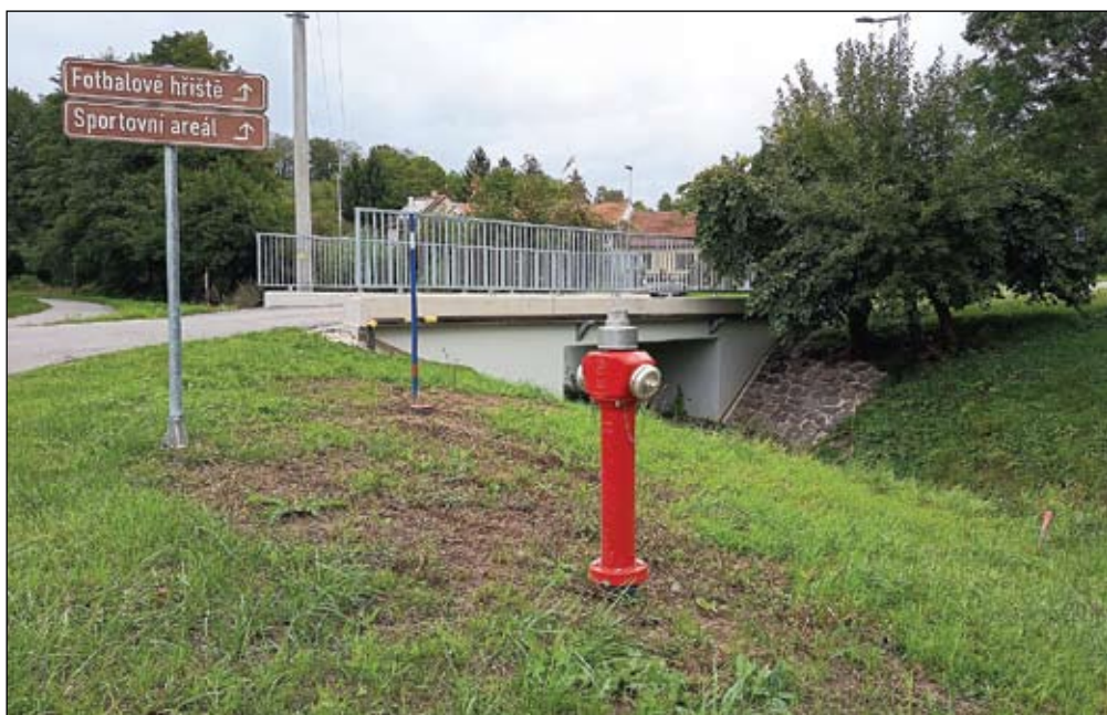
Rekonstrukce mostu přes Semíč s umístěním nadzemního hydrantu
